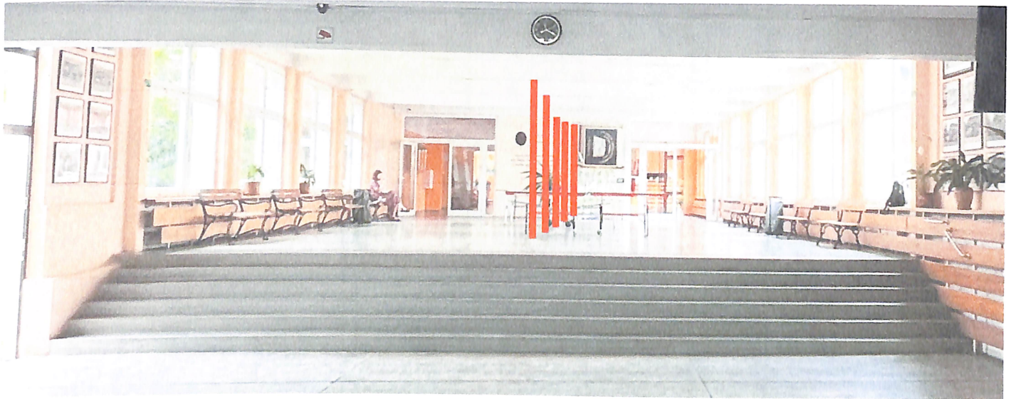
Fot. nr 2. Lokalizacja wzmocnień podciągów
