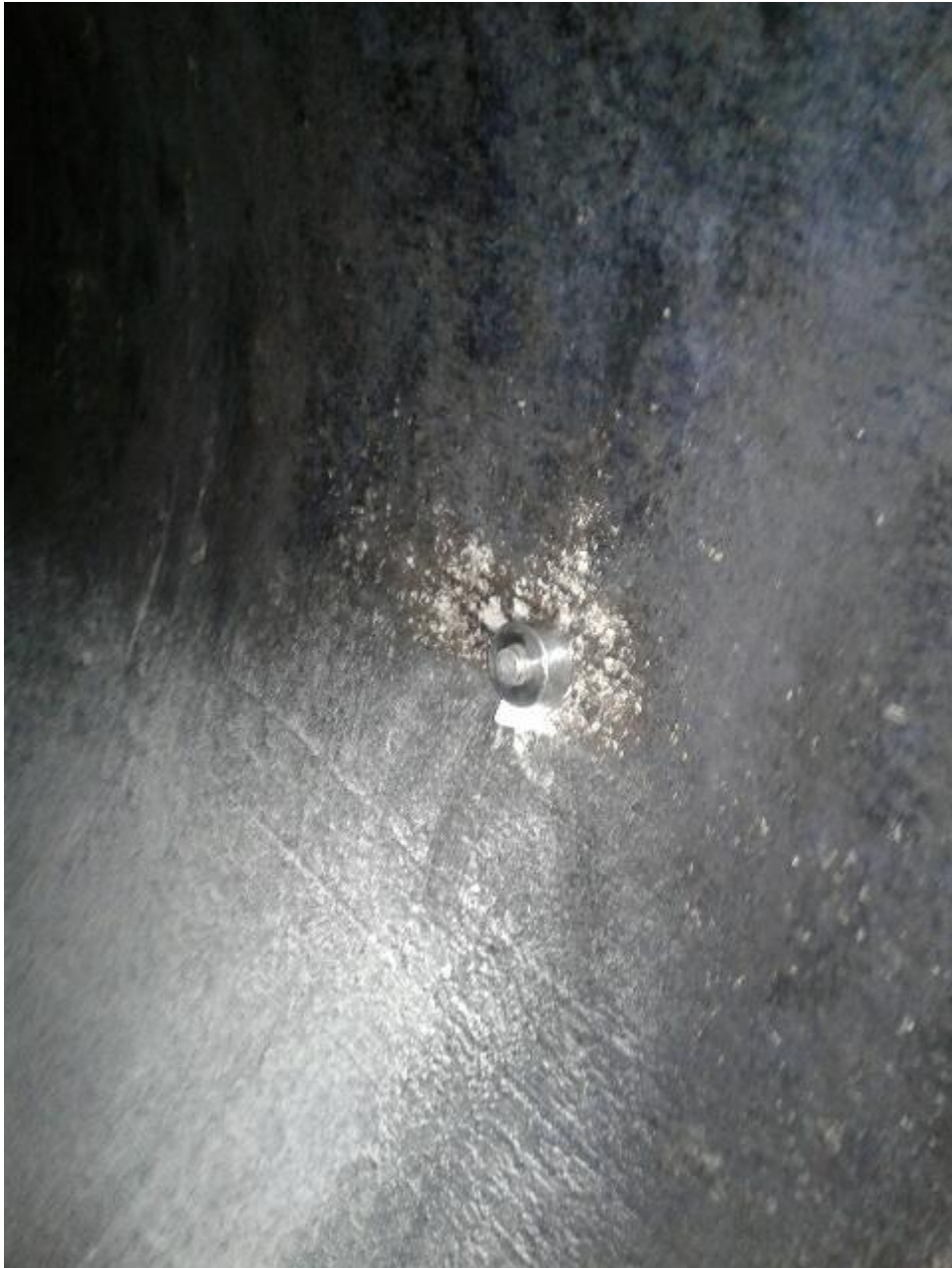
Fot.2.5 Odcinek K5-K6
