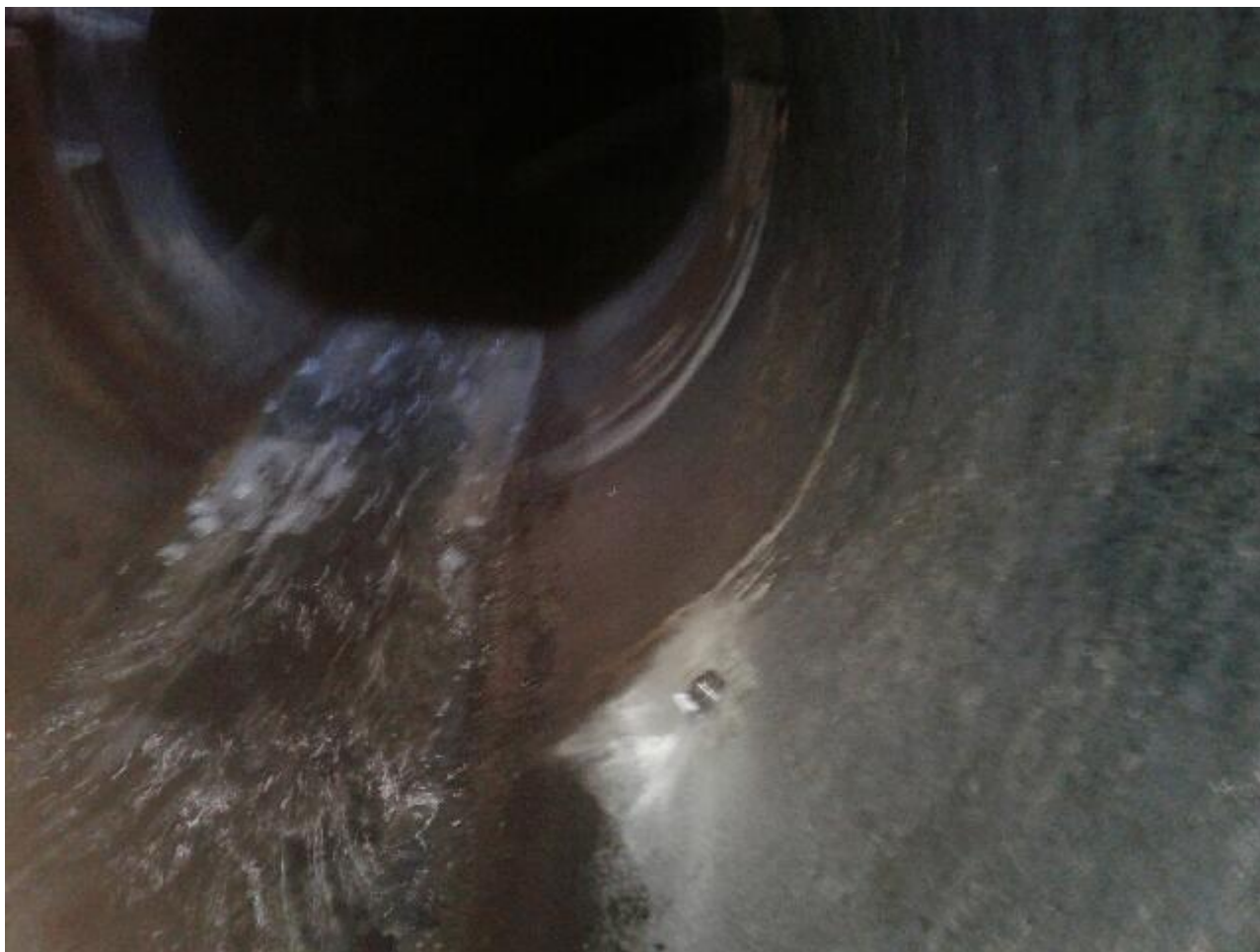
Fot.2.3 Odcinek K3-K4
