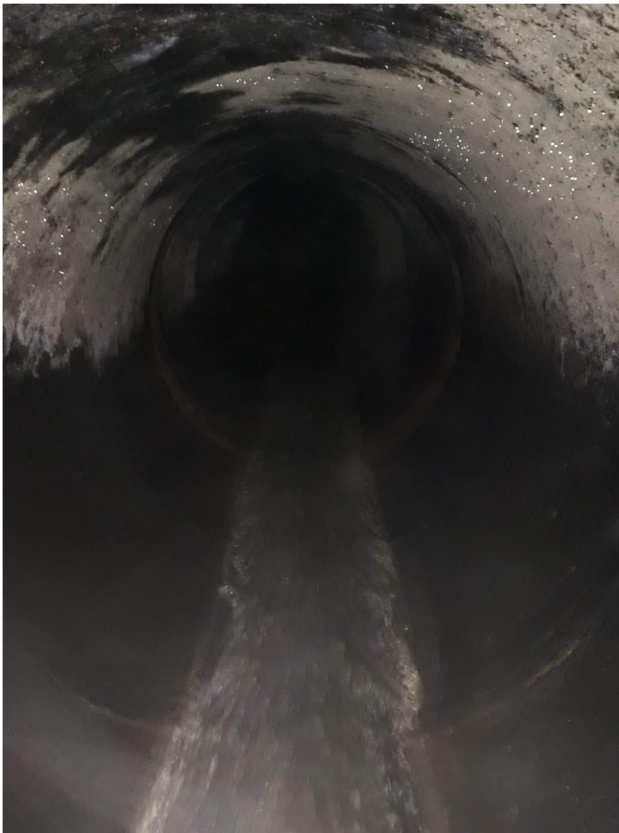
Fot.2.1 Odcinek K1-K2
