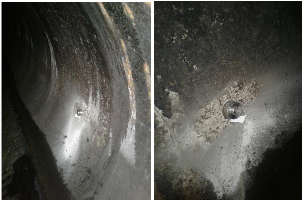
Fot.2.4 Odcinek K4-K5
