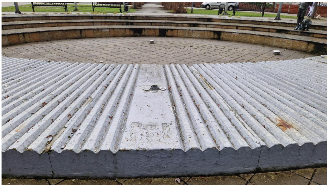
Ilustracja 3: Pęknięcia i uszkodzone elementy atrakcji wodnych w obrębie mostka
