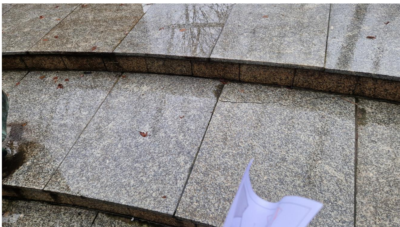
Ilustracja 4: Pęknięta płyta granitowa stopni
