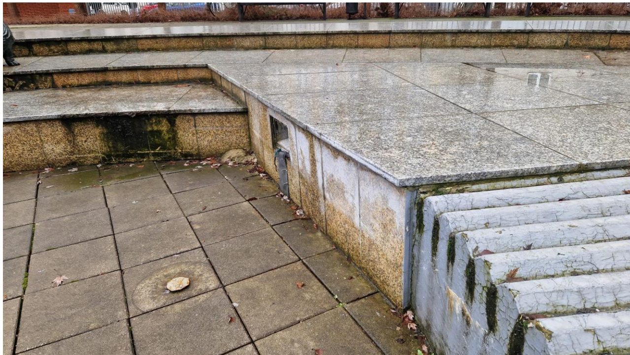
Ilustracja 2: Uszkodzenia struktury betonowej mostka oraz zabrudzone okładziny granitowe stopni
