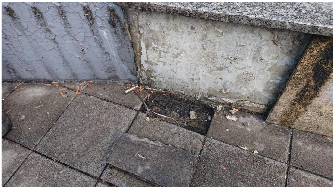
Ilustracja 5: Ubytek okładziny granitowej oraz płytki betonowej dna niecki
