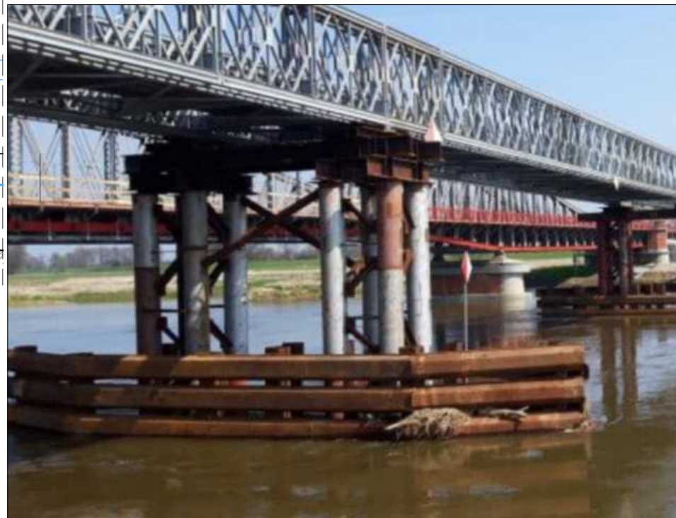
Fot.1 Przykład zastosowanej podpory tymczasowej w korycie rzeki Warty.
