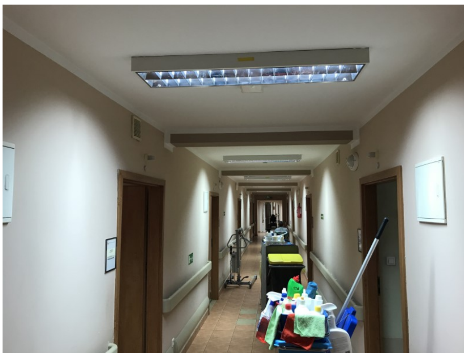
Fot.4 Stropodach i ściany ostatniej kondygnacji
