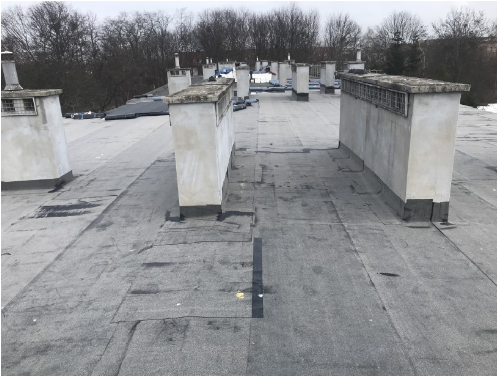
Fot.7 Widok połaci dachu
