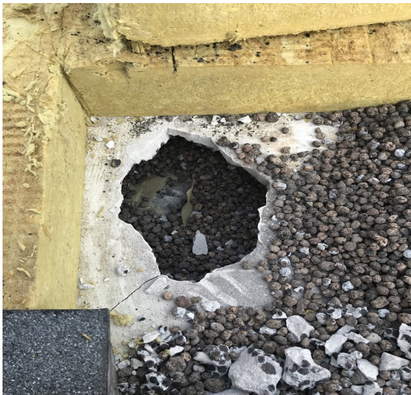
Fot.1 Odkrywka warstw spadkowych stropodachu na budynku 4 kondygnacyjnym
