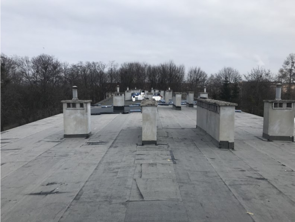
Fot.8 Widok połaci dachu
