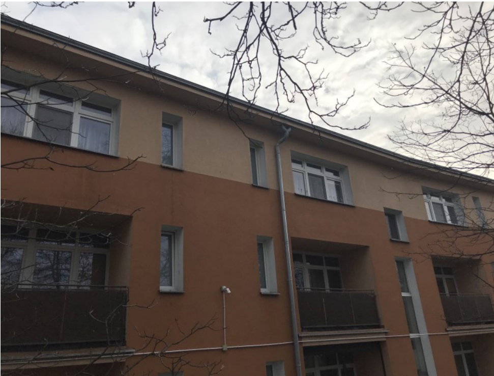
Fot.9 Widok elewacji zachodniej
