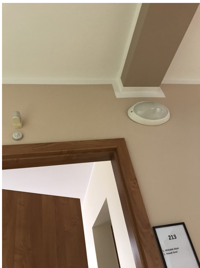
Fot.6 Żebra i ściany poręczne ostatniej kondygnacji
